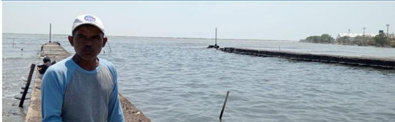
Nelayan di kawasan pesisir Muara Sukalila, Kota Cirebon, mengeluhkan kondisi *breakwater* (bangunan pelindung pantai sebagai pemecah gelombang) dan tambatan kapal yang rusak parah sejak lebih dari satu dekade terakhir. Kerusakan yang dibiarkan begitu lama sangat merugikan karena kapal nelayan sering hancur saat diterjang ombak besar dan ditabrak kapal tongkang (tirto.id)
